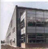
De nieuwe bedrijfshal van Van der Pols in Zuidland, ontworpen door Han de Kluijver, kenmerkt zich door een gepotdekselde gevelbekleding. De vezelcementplaten met eternit toplaag zijn ook gebruikt om de bestaande bebouwing te bekleden, waardoor een eenheid ontstaat.
